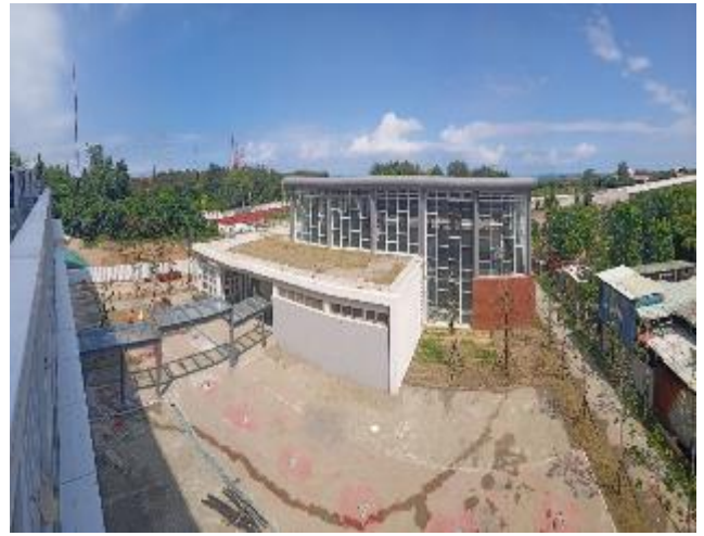
水上救生訓練館及聯絡走廊外觀
