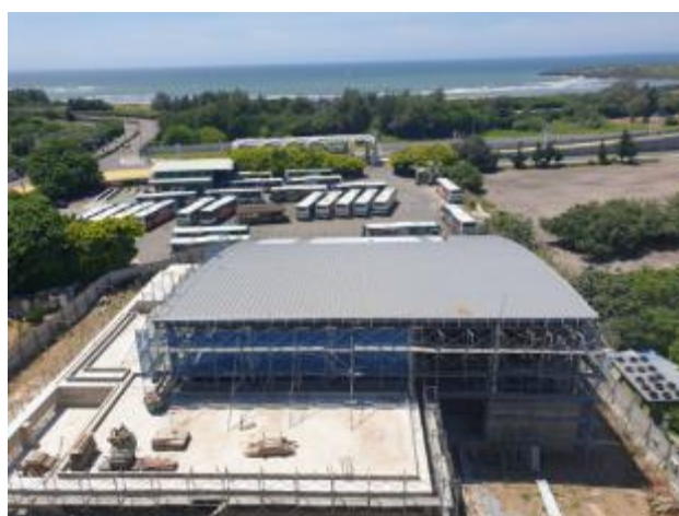
水上救生訓練館組裝鈦鋅屋頂瓦片
