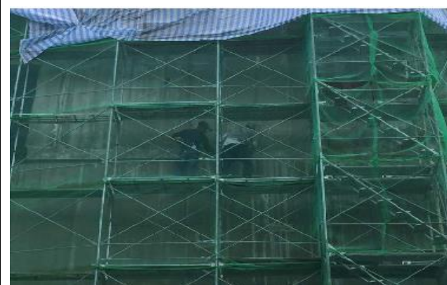
嘉義備災中心外牆塗料施作
