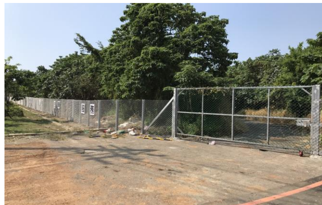
大台北備災中心簡易圍籬設置工程
