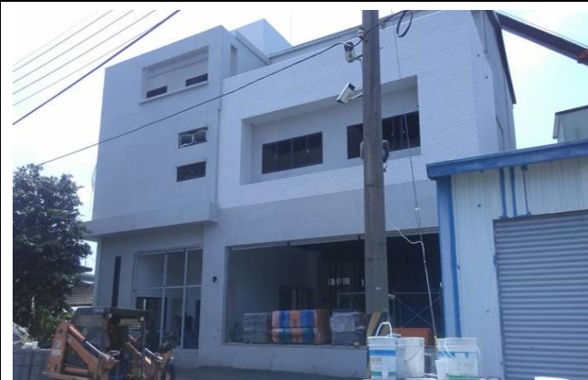
嘉義備災中心正面施作狀況
