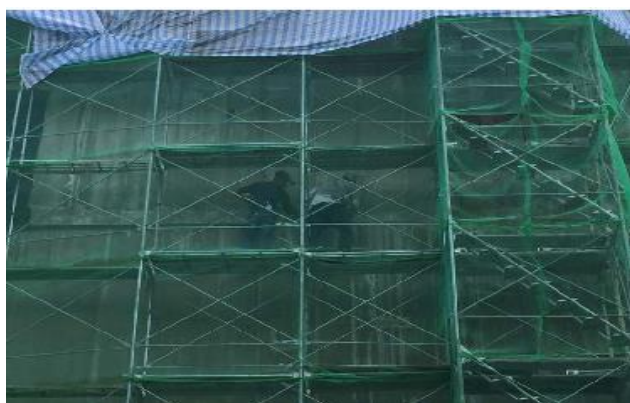
嘉義備災中心外牆塗料施作
