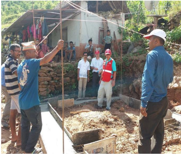
同心合力為新屋打造穩固及抗震地基
