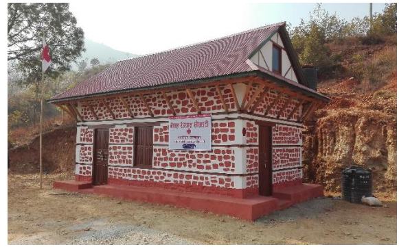
竣工的耐久屋提供災民安身立命之所
