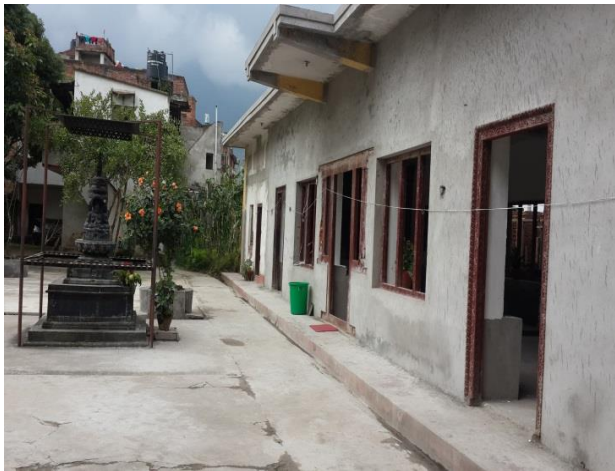
滿願寺整修後修行大樓外觀
