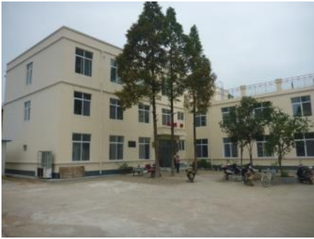
陝西省勉縣老道寺衛生院是本會援建 43 所衛生院之一，協助災後基層衛生系統的重建
