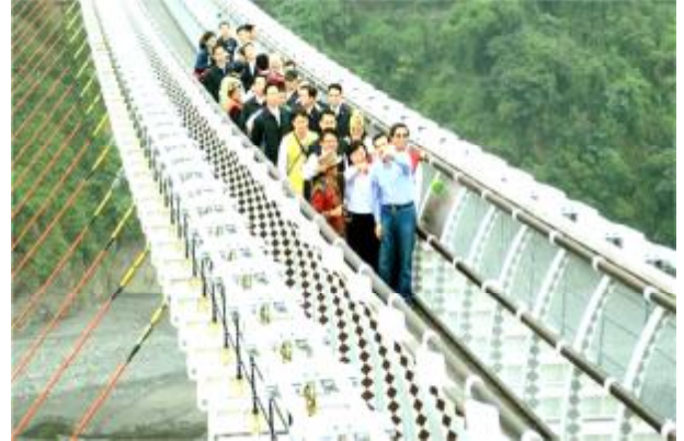
本會援建屏東縣三地門鄉山川琉璃吊橋，全長 263.25 公尺，是全國最長且優美的臥床式吊橋
